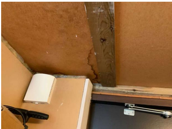
Bild 1: Invändigt, Källarplan, Förråd, Fläck i tak (från blomkruka)
