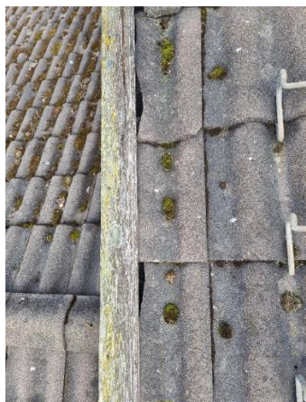
Vattbrädan täcker inte tillräckligt väl.
