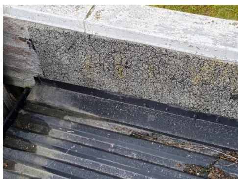
Gammal takpapp på garagetaket.
