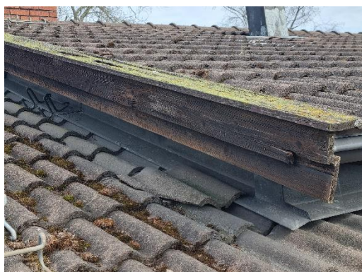
Uttjänt vindskiva och vattbräda.
