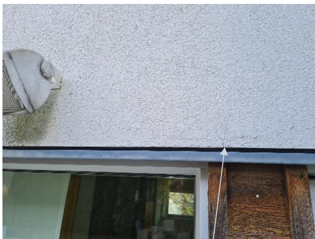
Bild 5 Exempel på lokal sprickbildning vid överbleck till träfasad
