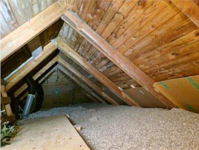
Vy på vindsutrymmet
