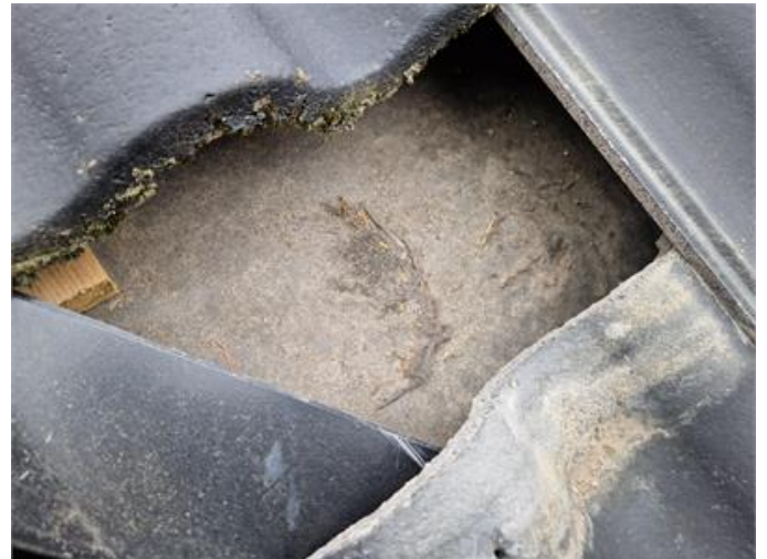
Vy på underlagstak
