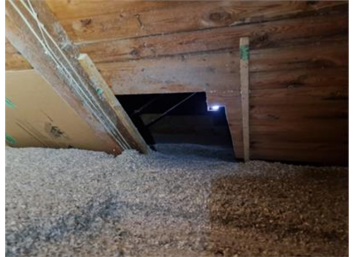
Vy på vindsutrymmet
