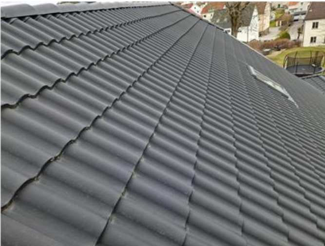
Vy på yttertak
