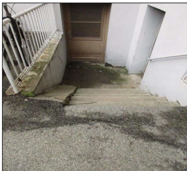
Nedgång till cykelgarage
