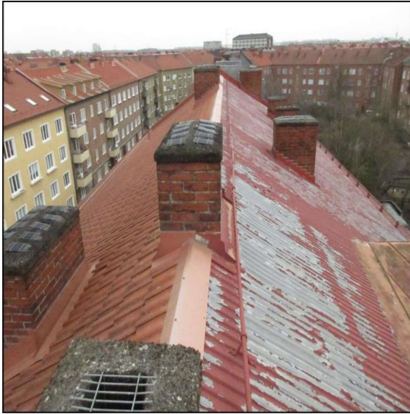
Plåttak mot innergård och tegel mot
