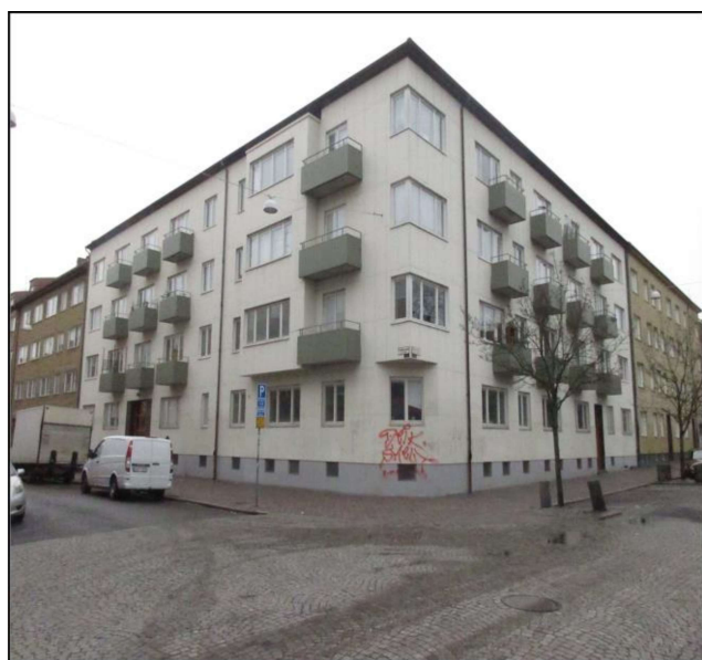
Fasad av skivmaterial mot gata
