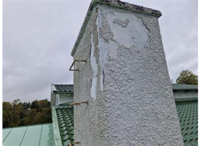
Skorsten med putsläpp
