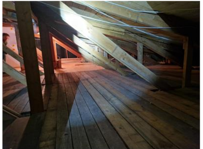
Vy på vindsutrymmet
