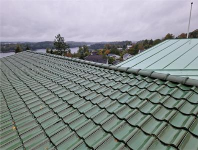
Vy på yttertak
