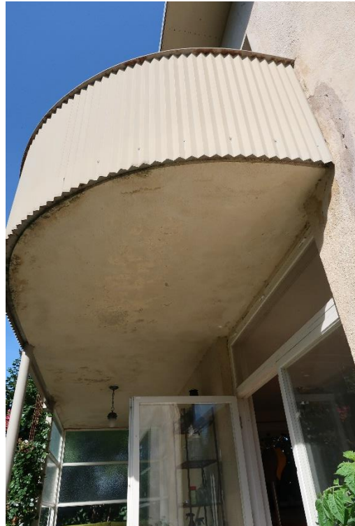
Spricka i västra hörnet och lagning och spricka vid sida av balkong. Undersidan på balkongen åtgärdades inte under renoveringen. Södra fasaden.
