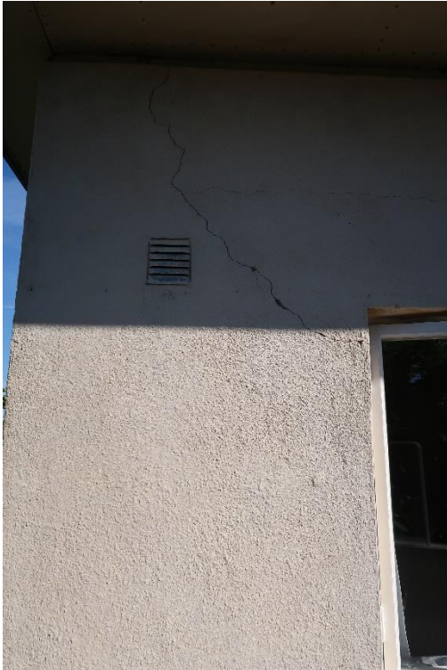
Spricka i västra hörnet och lagning och spricka vid sida av balkong. Undersidan på balkongen åtgärdades inte under renoveringen. Södra fasaden.
