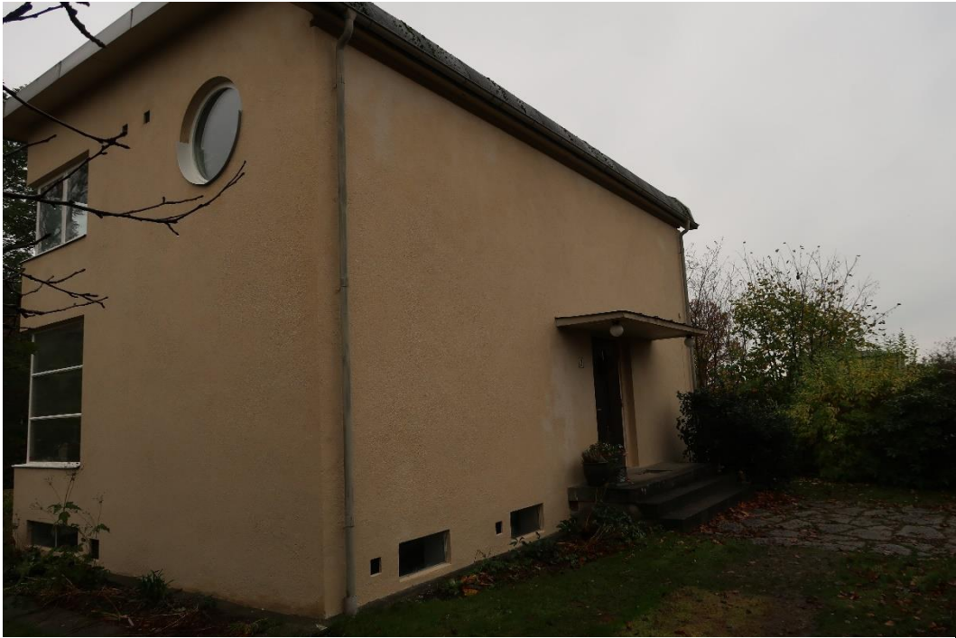
Norra fasaden efter restaureringen 2022.
