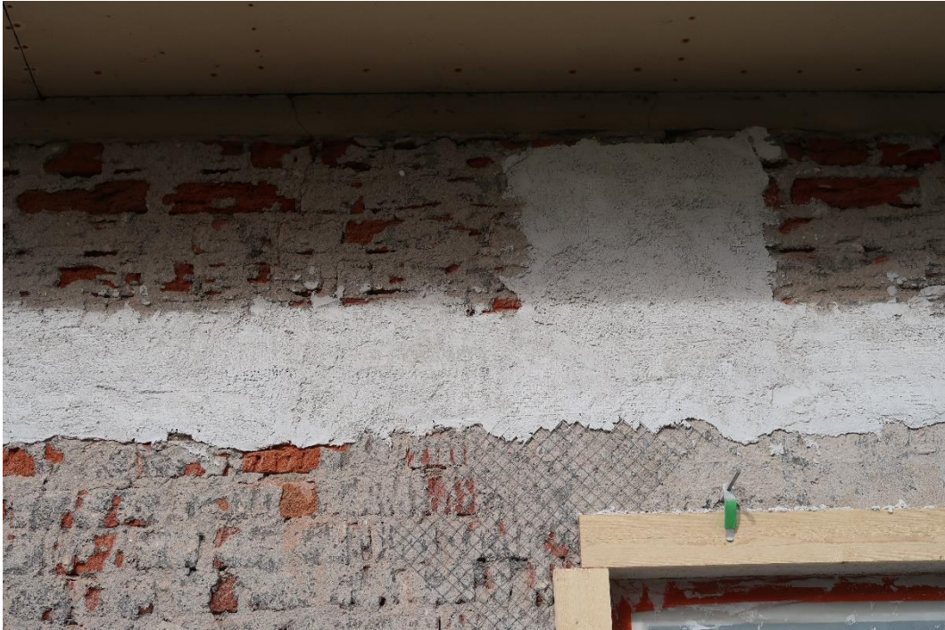
Nätning och lagning av den horisontella sprickan på södra fasaden.
