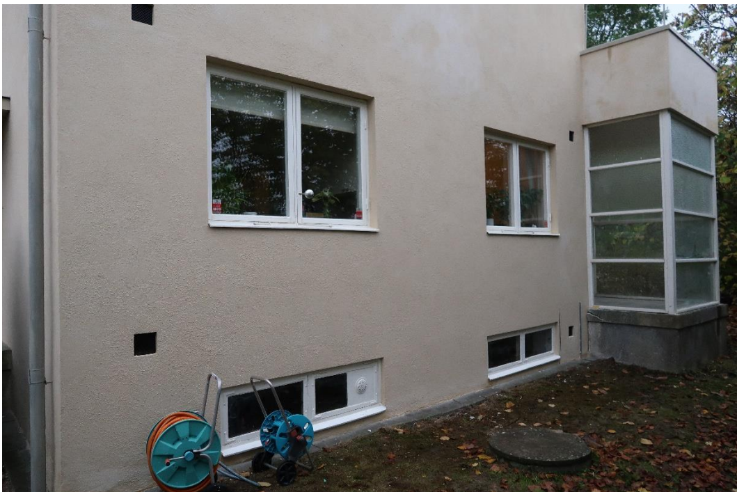
Västra fasaden efter restaureringen 2022.
