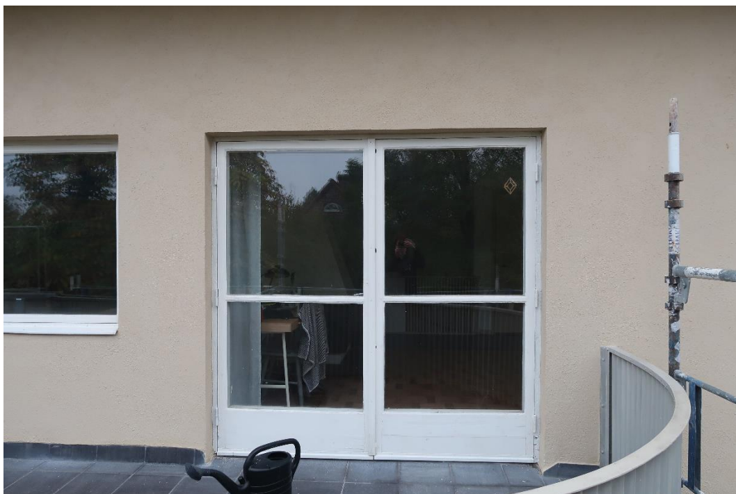
Efter att blecken tagits bort putsades hörnen.
