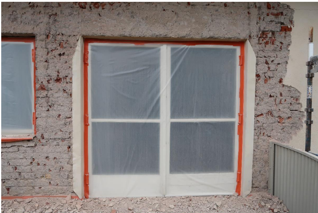
Metallbleck runt balkongdörrarna hade satts upp under tidigare restaurering. Södra fasaden.
