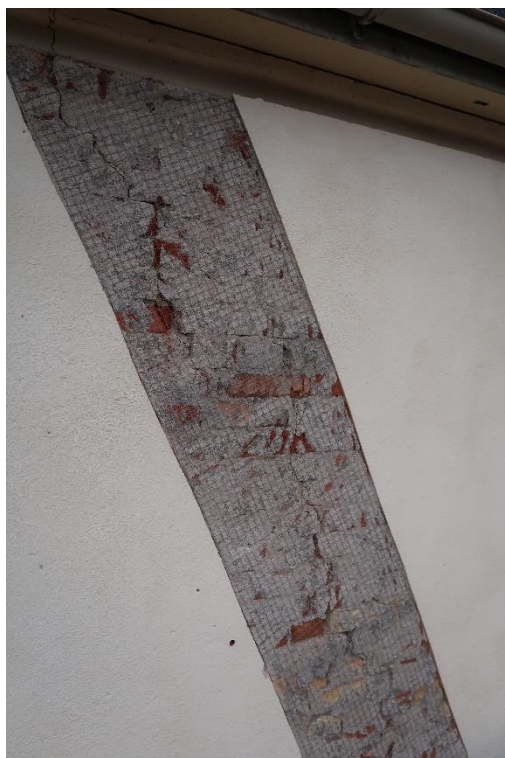
Spricka på norra fasaden innan åtgärd och efter att sprickan öppnats och nätats.
