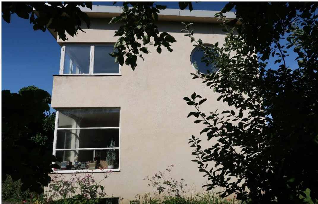
Östra fasaden innan restaureringen 2022.
