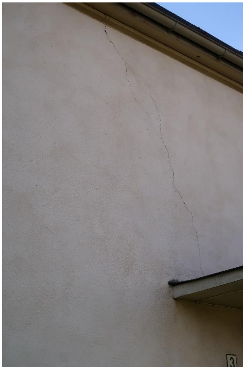
Spricka på norra fasaden innan åtgärd och efter att sprickan öppnats och nätats.
