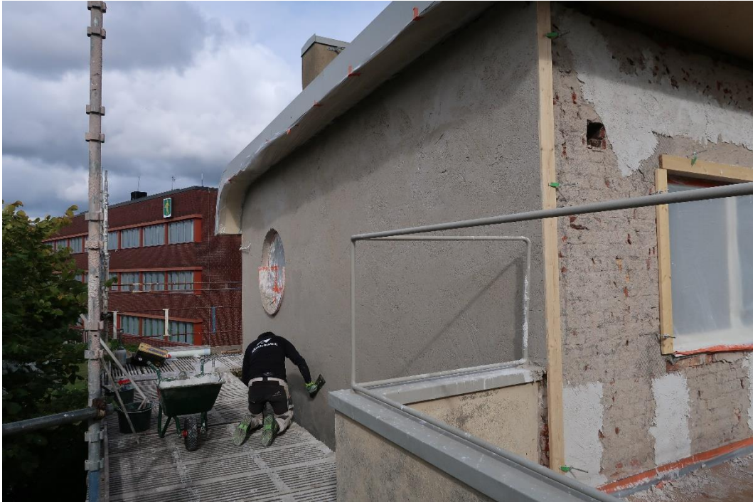
Västra fasaden under putsningsarbetet.
