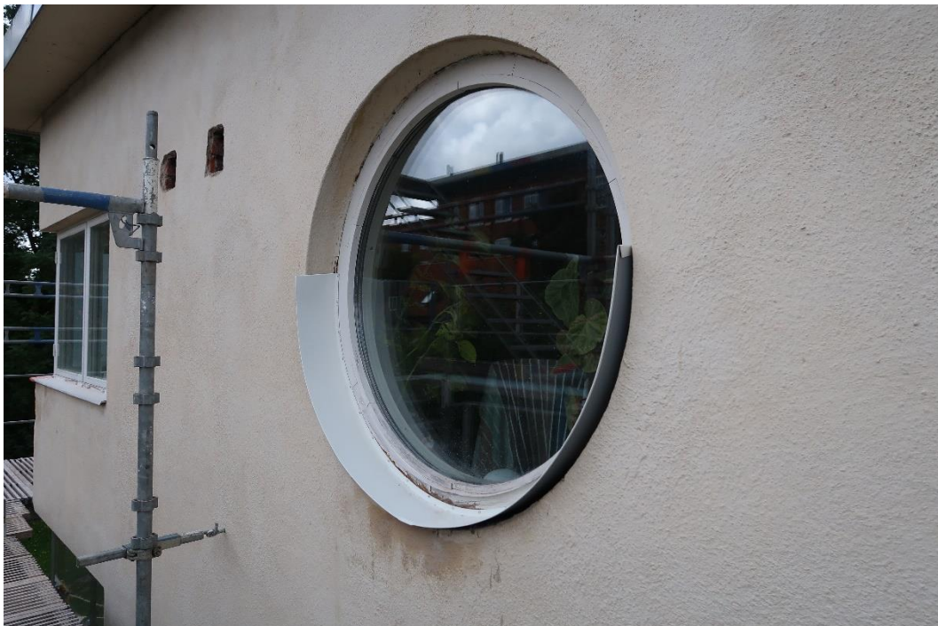
Nytt bleck på det runda fönstret på östra fasaden.
