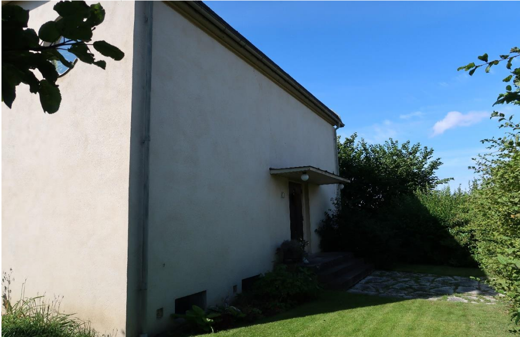
Norra fasaden före restaureringen 2022.
