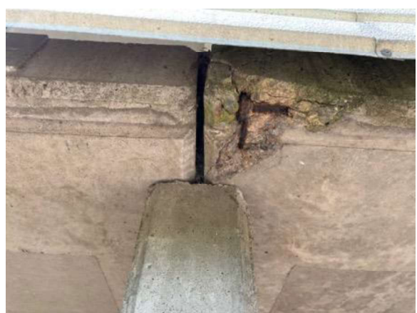
Betongskada loftgång, rostsprängning
