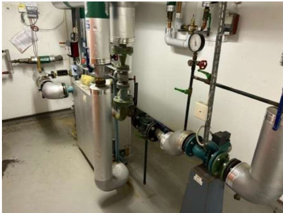
UC, Fjärrvärmväxlare
