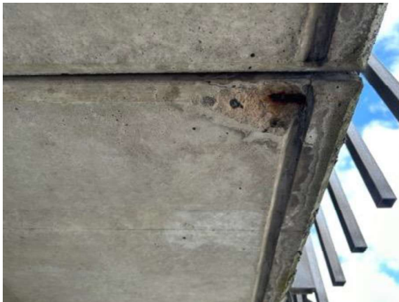
Betongskada balkong, rostsprängning
