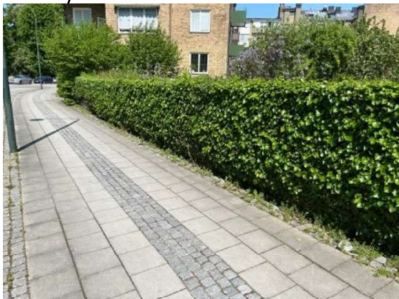
Planteringslåda utreds m.a.a. befarade rötskador
