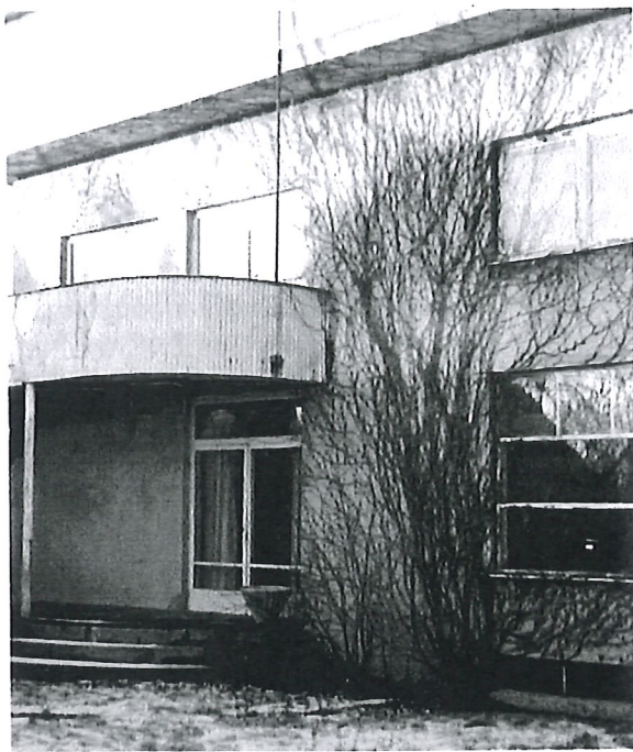
Södra sidan med balkongen som rostade på grund av att balkonggolvet tätats.
