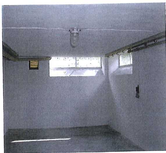
Torkrummet med ursprunglig armatur och krokar för tvättlinor.
