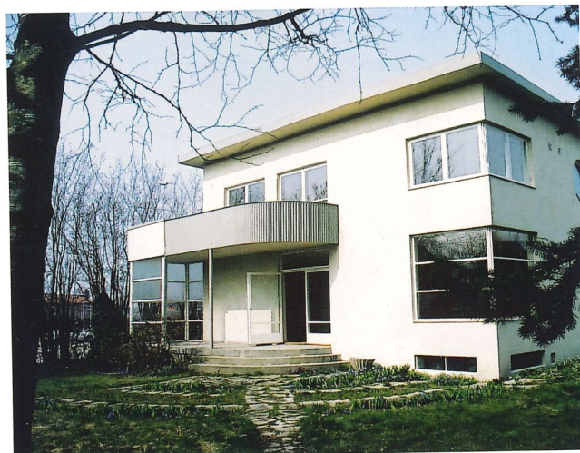
Funktionellt formspråk: raka linjer med fönster som bryter av fasadhörnen. Inga dekorer eller burspråk. Svängda former i terrasstrappan och balkongen. Båtfönster till höger.
