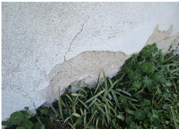
Sprickor och putssläpp längs sockeln
