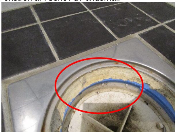
Fog och fix täcker anslutningen tillklämring
