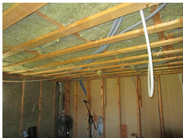
Badrum är under uppbyggnad
