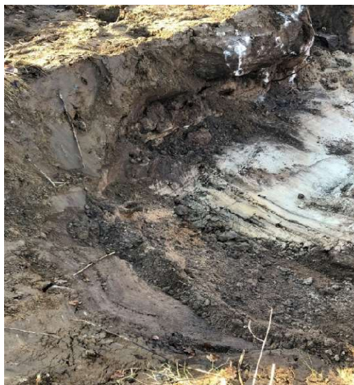
Figur 12 Krater bortgrävd parkslide, man grävde ca 1 m-2 m djupt under terrass höjd.
