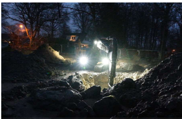
Figur 10 Fler djupa hål som grävdes. Kontaminerat material redo för nedgrävning syns i hög till vänster om maskinen.
