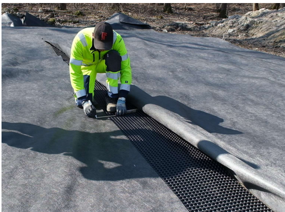
Figur 19 Markering av överlapp längs hela sidan 100mm enligt tillverkare spec.
