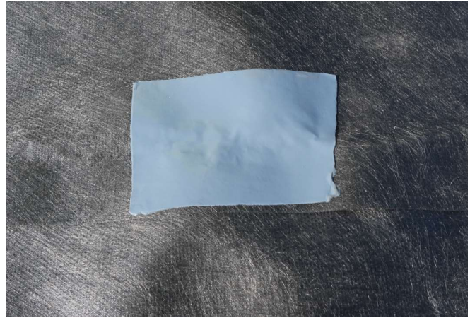
Figur 24 Lagat hål med medföljande dubbelhäftande vulktejp enligt duk leverantörens material och specifikationer. En bit duk placerades sedan ovanpå den dubbelhäftande tejbiten
