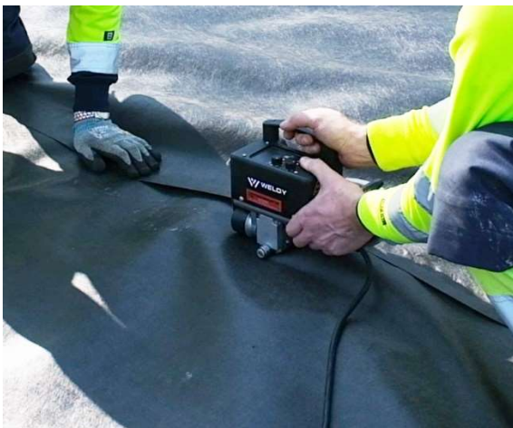
Figur 21 Närbild svets utrustning i arbete!
