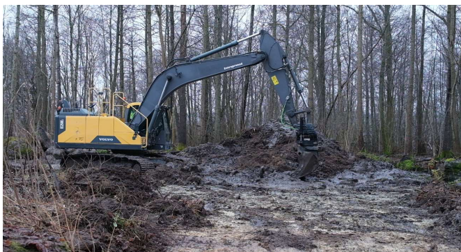
Figure 6 Material placerades i högar i väntan på nergrävning
