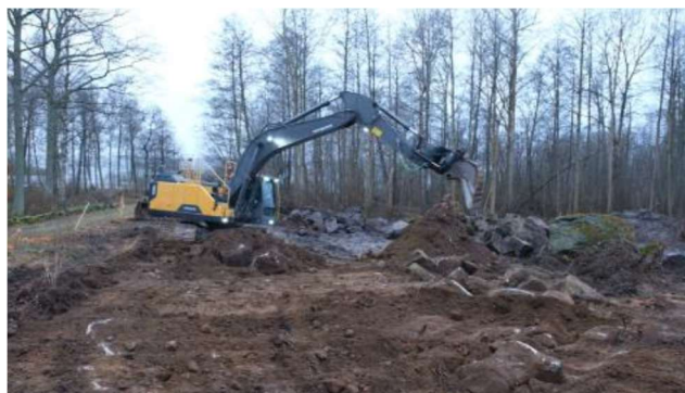
Figure 7 Material placerades i högar i väntan på nergrävning
