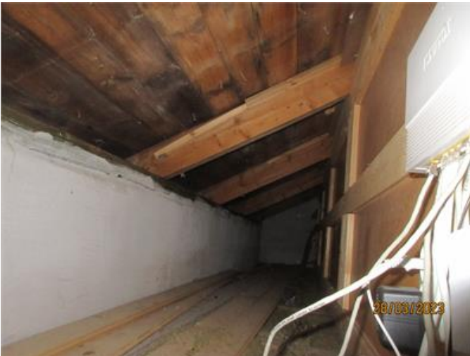
Mikrobiell påväxt förekommer på underlagstakets undersida, se kommentar/riskanalys.
