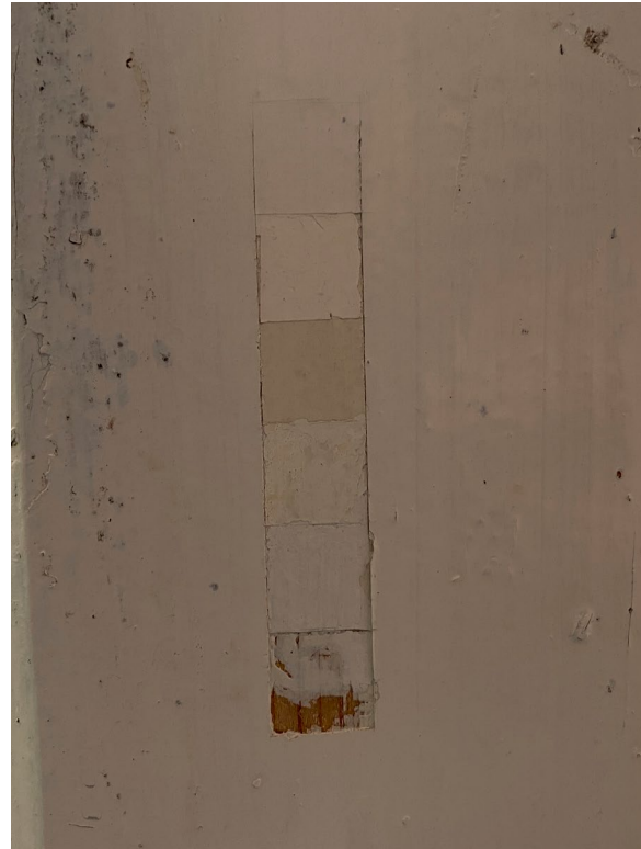
Färgtrappa utförd på en stolpe vid en entré åt Husumsgränd.
