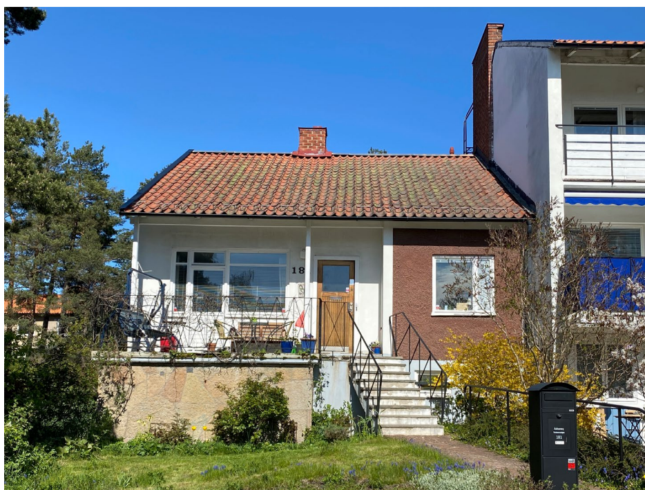
Vivstavarvsvägen 181 är ett fint exempel på en exteriör som i hög grad bevarar sitt ursprungliga utseende.
