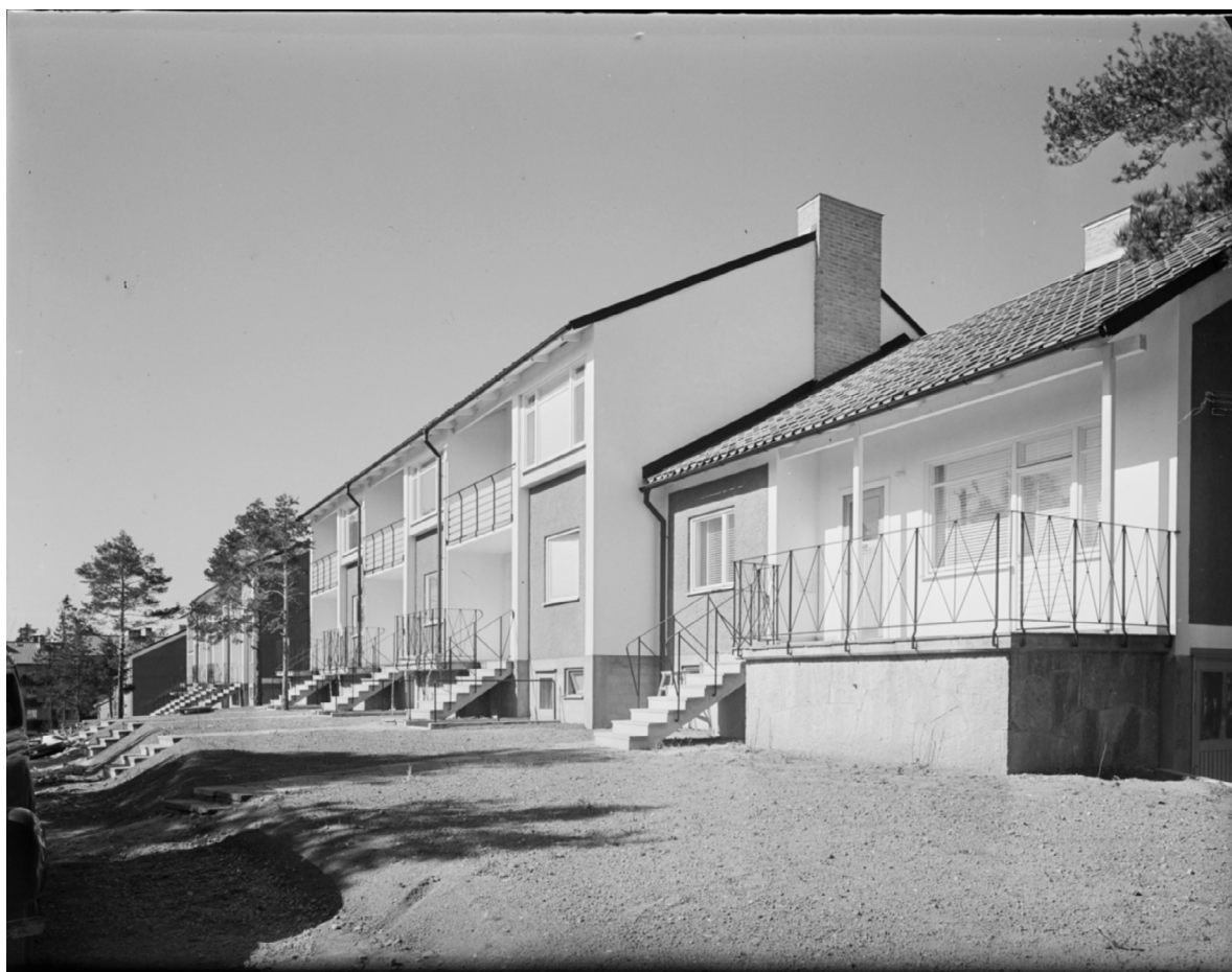
Östra delen av Vivstavarvsvägen fotograferad 1952. Smidesräckena har här en för 1950-talet typisk form. På andra fasader, som exempelvis balkongerna på föregående sida, är smidet enklare utformat närmare den tidiga funktionalismens smidesarkitektur.
