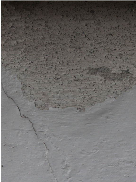
Bildens övre del visar originalkulören för fasadernas vita släta partier (ca S 0603-Y20R).
