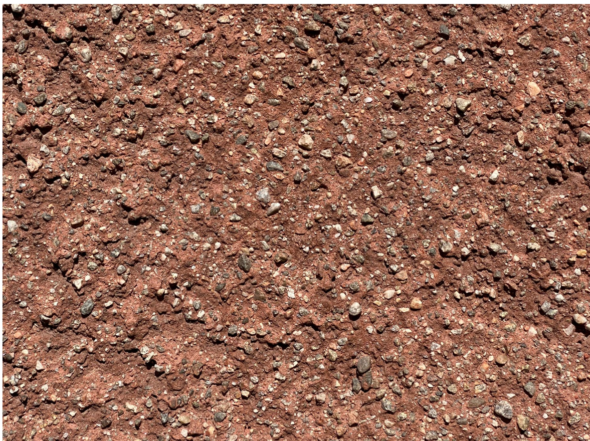
Välbevarad originalputs på Vivstavarvsvägen. Den högkvalitativa putsen har åldrats väl under 70 år!
