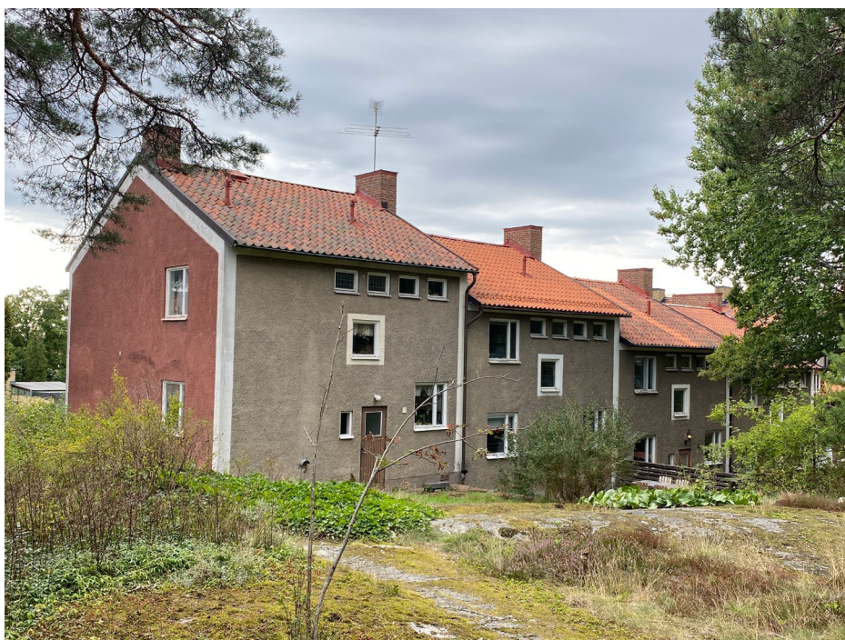
Gårdsfasaderna på norra delen av Vivstavarvsvägen fotograferade från sydöst.
