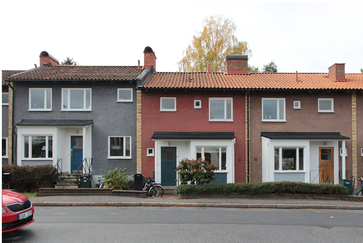
Spritputsade fasader åt Husumsgränd (34–38).
