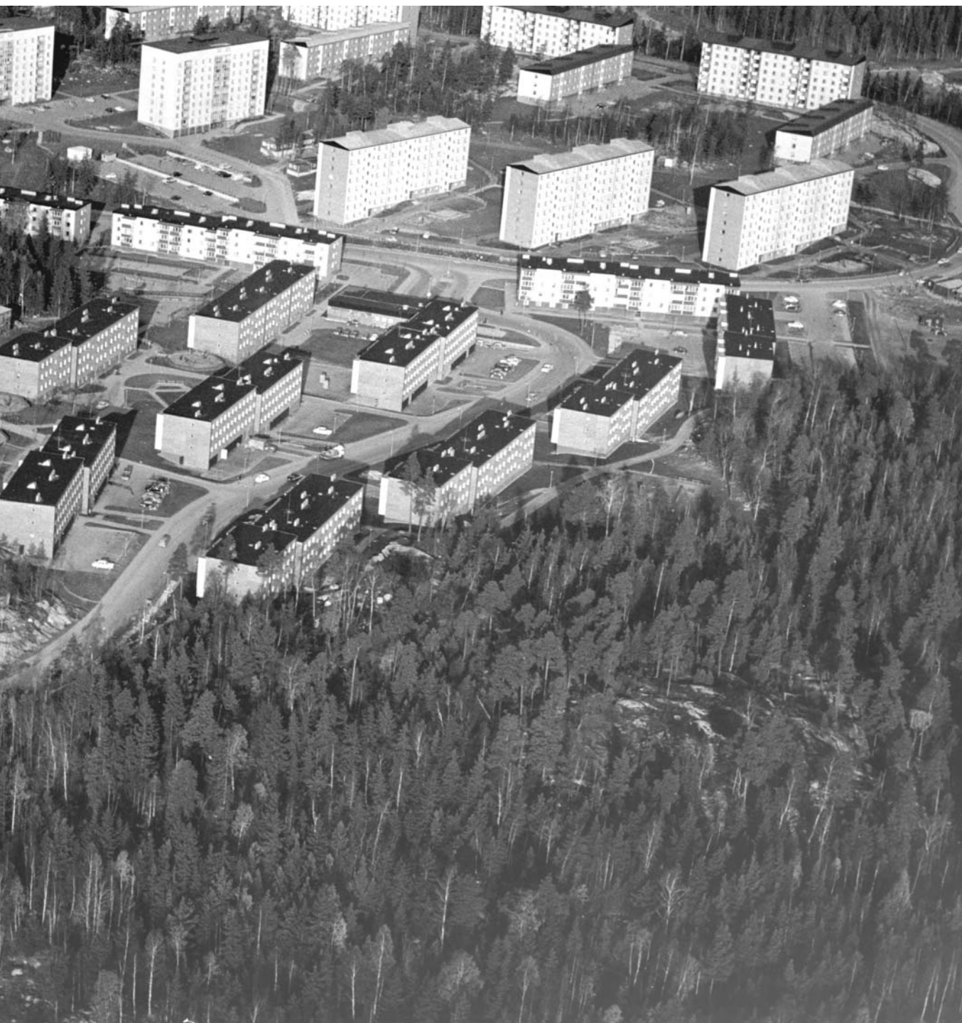
Nästan färdigbyggt hösten 1963 (byggkranen står kvar vid den bortre delen av höghuset).
