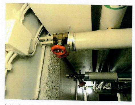
Avstängningsventiler i källaren saknar märkning
