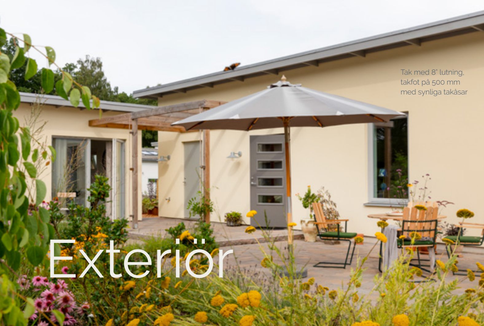
Sadeltak med tvåkupiga betongpannor och minimal takfot
