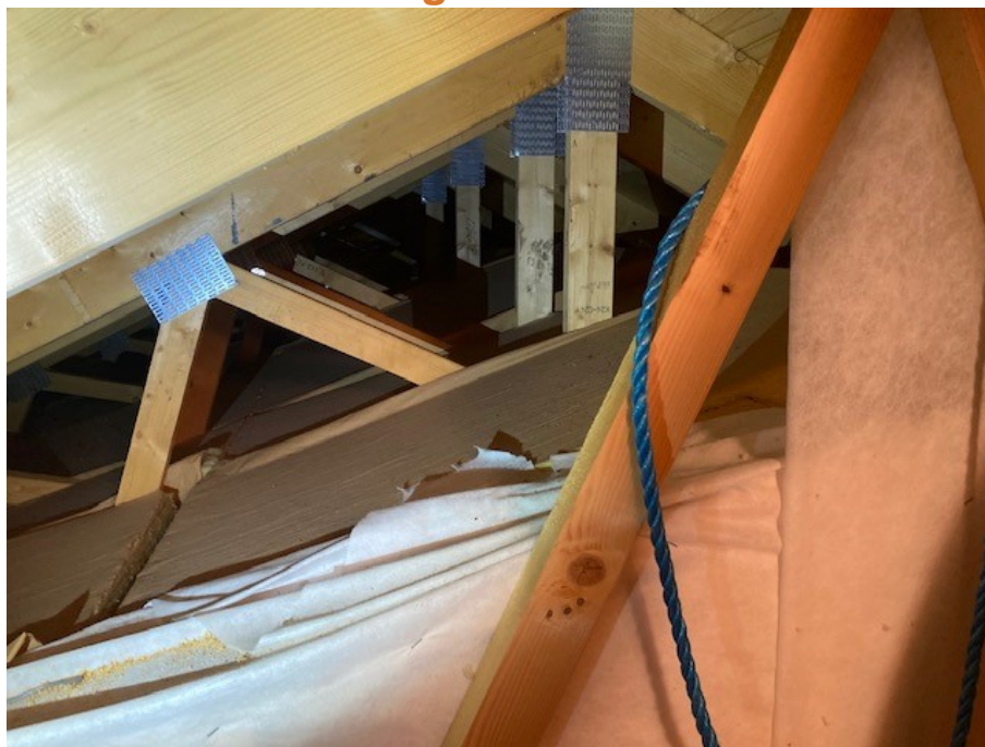
Begränsat utrymme på vind över vardagsrum.
