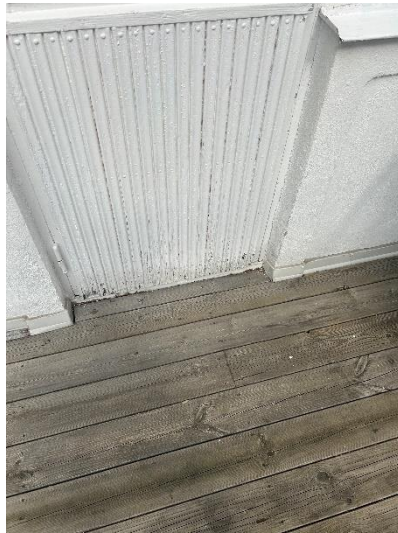
Altandörr, rötskador/torrspäckor.
