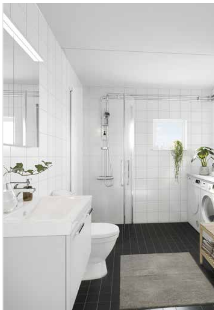
I samtliga av våra badrum är det utanpåliggande rör. Dessa är alltid i ett kromat utförande.
